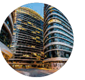
Edificio de oficinas
